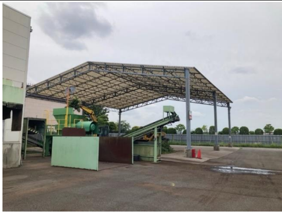
一次破砕機(奥は原料棟)
