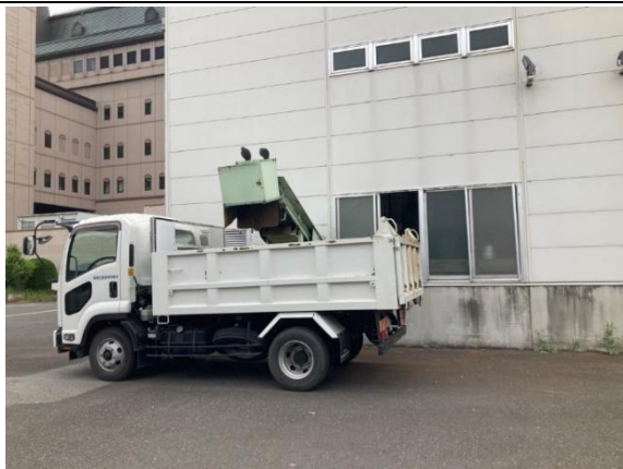
三次破砕機後の積込み
