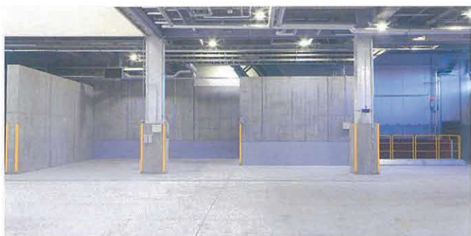
7 不燃ごみ受入ヤード・粗大ごみ受入ヤード 搬入された不燃ごみと粗大ごみを一旦保管するための場所です。ここからショベルローダでそれぞれの受入ホッパへ投入します。
