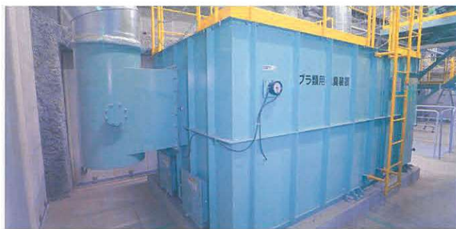
8 プラスチック類用脱臭装置・不燃粗大用脱臭装置 各所から発生する臭気を活性炭で吸着して、クリーンな空気として屋外に排気します。
