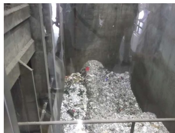
ごみピット内
