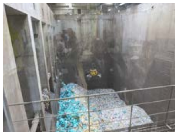
ごみピット内
