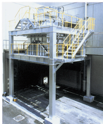
▲ 処理飛灰バンカ 飛灰固化物は、このバンカに一時貯留される。
