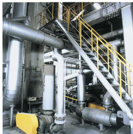
▲ 処理飛灰バンカ 飛灰固化物は、このバンカに一時貯留される。
