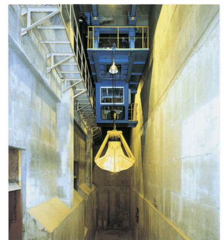
▲ 処理飛灰バンカ 飛灰固化物は、このバンカに一時貯留される。
