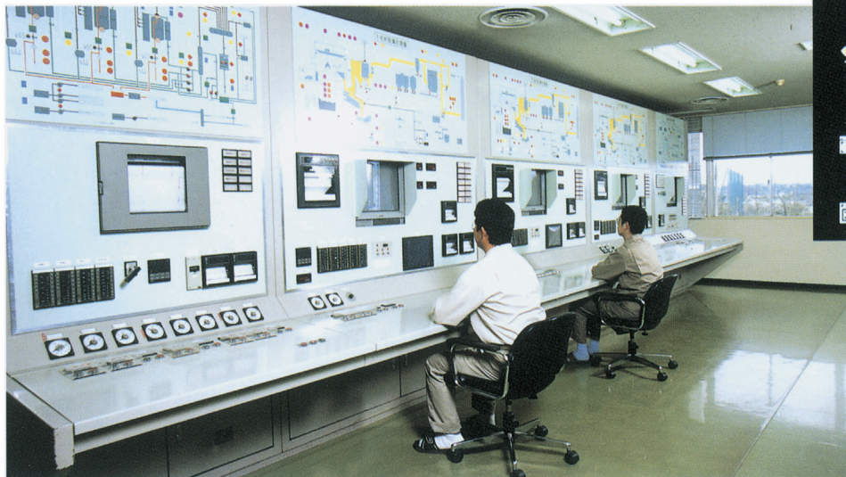
▲ 中央制御室 焼却炉の運転はこの中央制御室にてリモートコントロールする。
