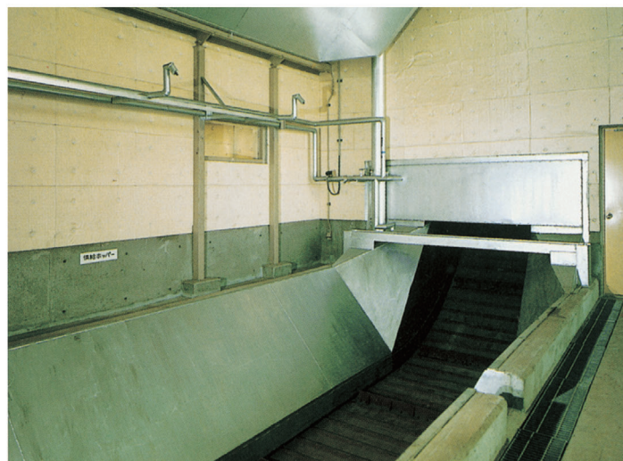
そだい ③ 粗大ごみピット
