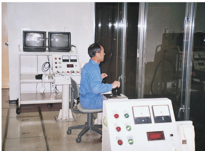
④ ごみクレーン操作室
