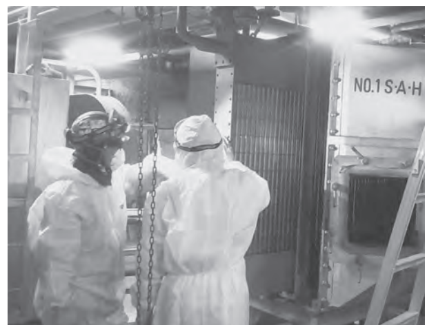
1号炉 蒸気式空気予熱器の熱交換器交換作業
